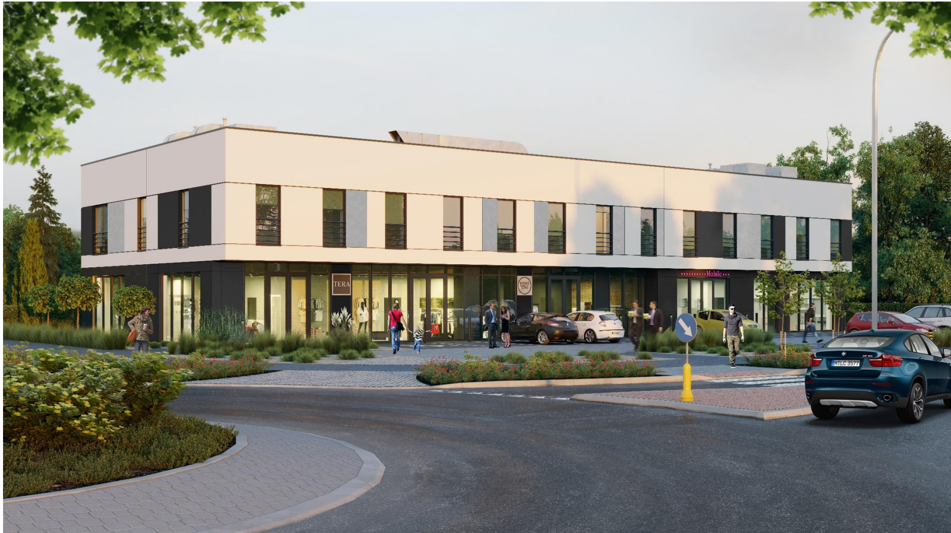
BUDYNEK USŁUGOWO-BIUROWY PRZY UL. REKRUCKIEJ W WARSZAWIE
